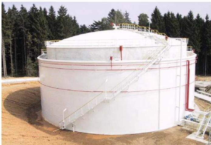
фиг. 2.4 Резервоари с двоен корпус
