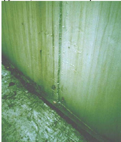
фиг. 2.1 Вертикален монтажнен шев с припокриване
