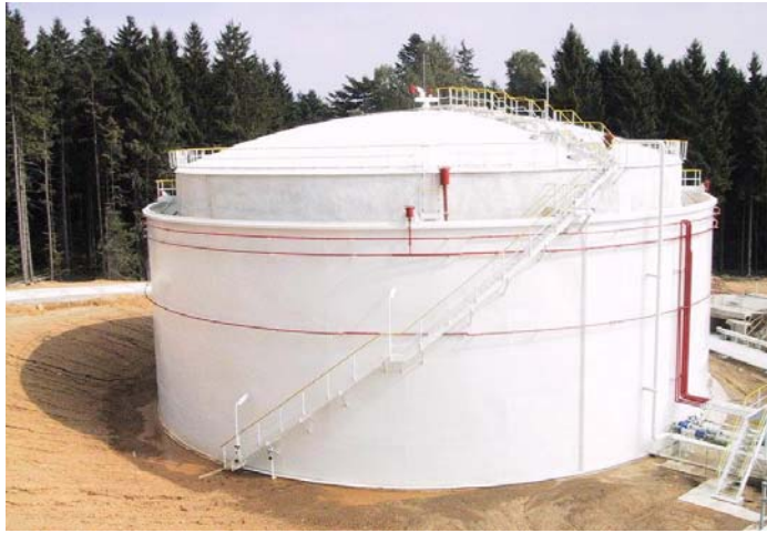
фиг. 5 Резервоари с двоен корпус
