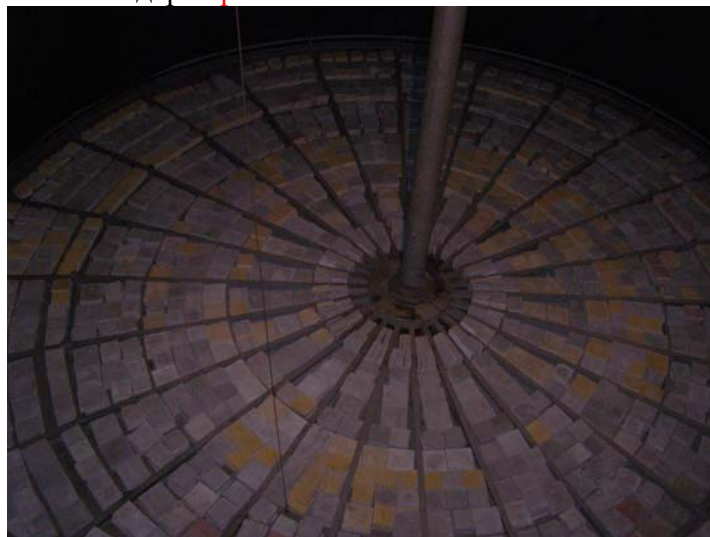
фиг. 2 Подвижен таван и телескопична колона
