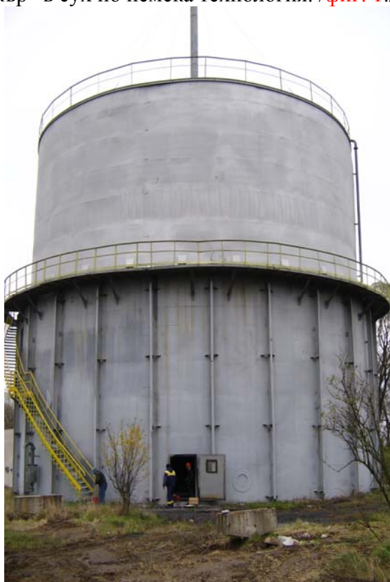
фиг. 1 Общ изглед на реконструирания газхолдер
