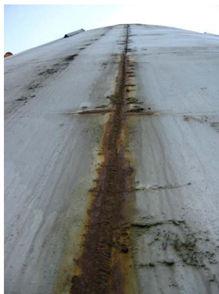
Фиг. 2. Монтажен вертикален шев
