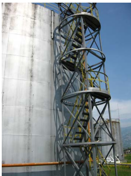
Фиг. 1. Стоманен резервоар – общ вид
