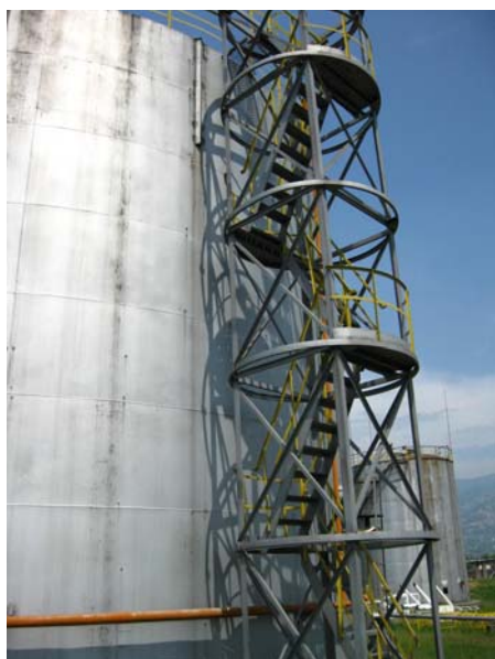
Фиг. 1. Стоманен резервоар – общ вид
