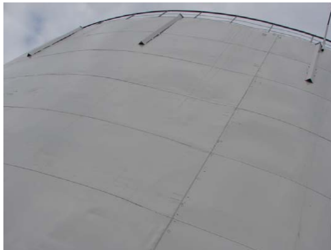
Фиг. 6. Монтажен вертикален шев в корпуса, изпълнен с припокриване
