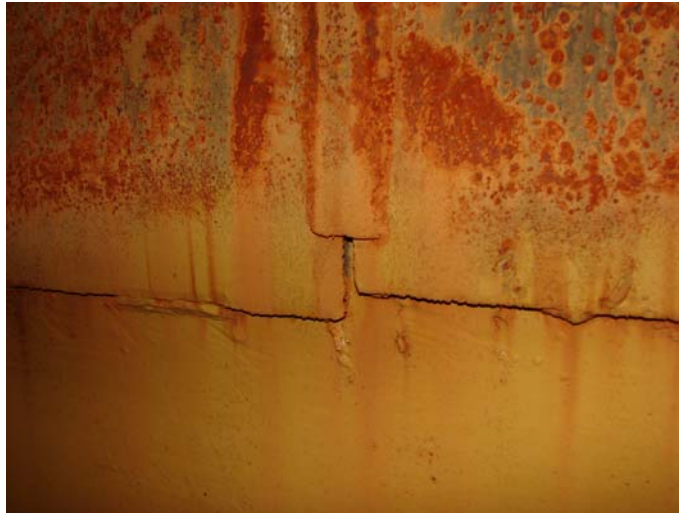
Фиг. 5. Стоманени шини по вертикалните шевове в корпуса
