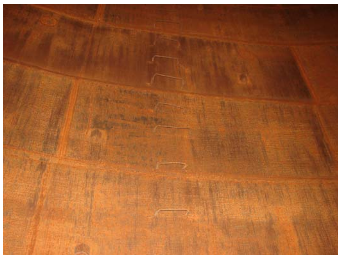
Фиг. 2. Вертикална стълба от вътрешната страна на корпуса
