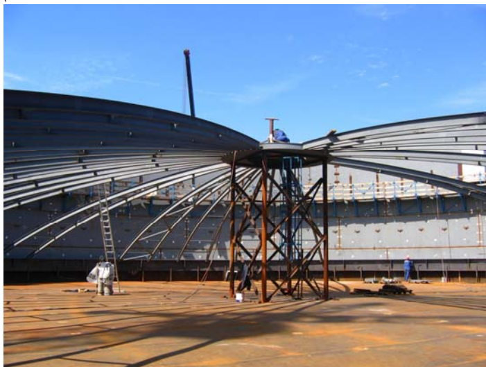
фиг. 3 Временна опора при монтажа на покрива
