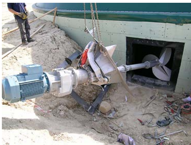
фиг. 7 Стоманобетонен корпус
