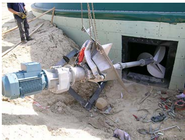
фиг. 7 Стоманобетонен корпус
