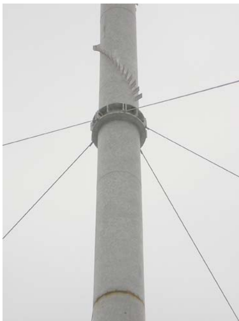
фиг. 4 Централна телескопична стойка с обтегачи
