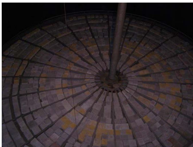
фиг. 3 Подвижен таван с централна стойка
