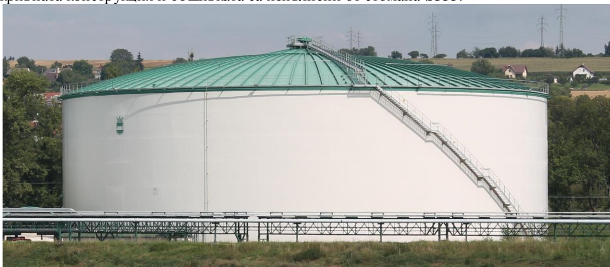
фиг. 1.1 - Стоманен резервоар с обем V=70\,000\text{ m}^3 за меласа
